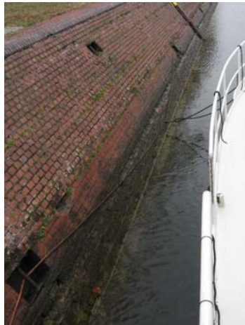
Schleuse in Rathenow mit schrägen Wänden
