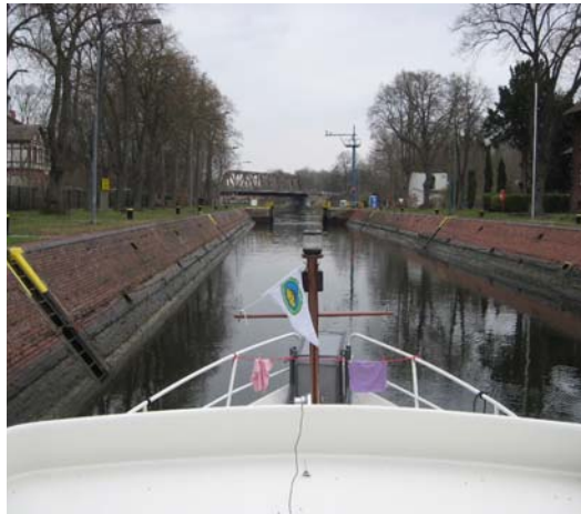
Schleuse in Rathenow mit schrägen Wänden
