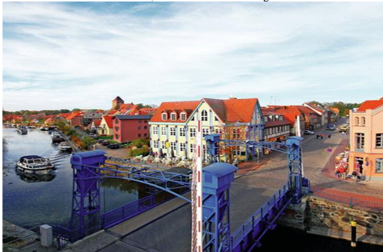
Hubbrücke Plau am See; hebt sich in Verbindung mit der Schleuse.
