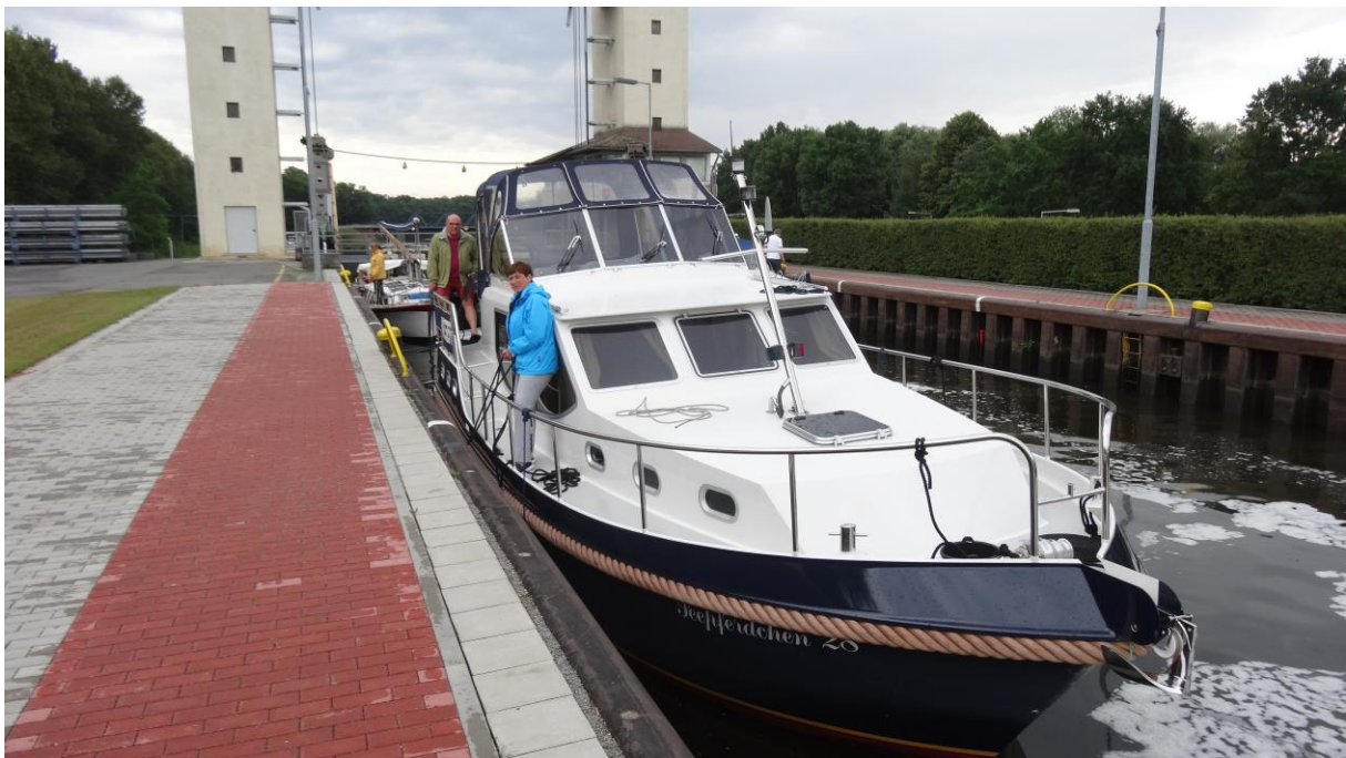
Auch in der Schleuse Lehnitz ist das Schleusen kein Problem
