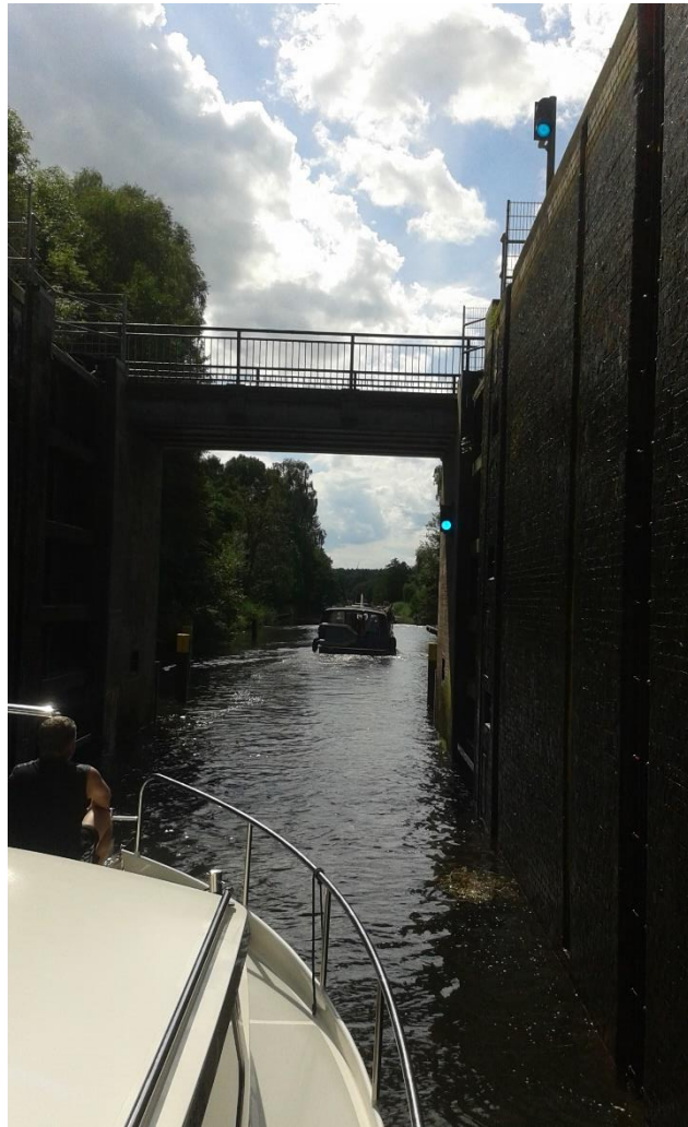
Schleuse Bobzin mit Höhenunterschied 6,80 m
